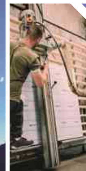
Découpe d'un panneau sandwich à la bonne taille pour fabriquer le volet Alu.
